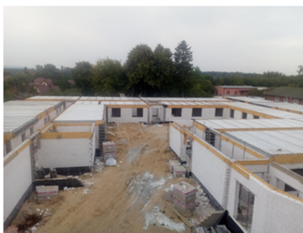
Zdjęcie nr 4. Plac budowy - nowy rozbudowywany budynek Domu Pomocy Społecznej.
