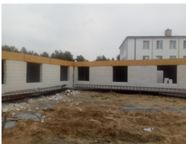
Zdjęcie nr 3. Plac budowy – nowy rozbudowywany parterowy budynek z zewnątrz
